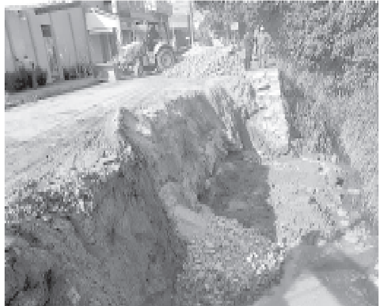
As obras emergenciais estão sendo realizadas no entorno do Córrego Cafuá, e a previsão é que fique pronto em 30 dias
